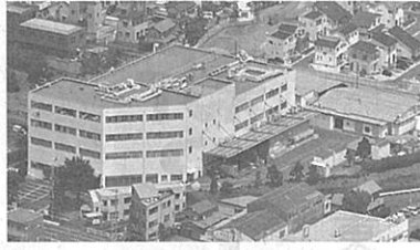
三福工場の全景
